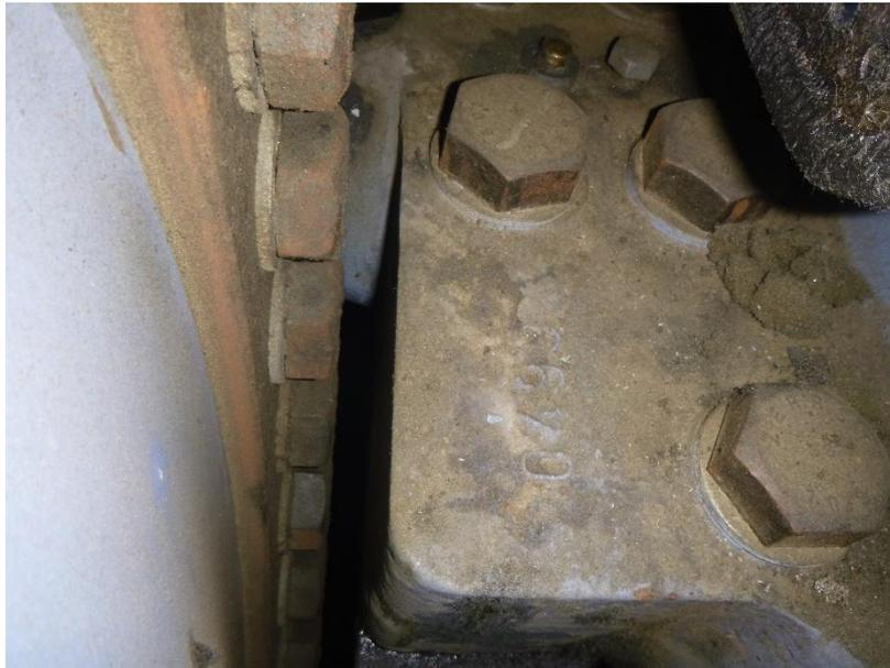
I0124989: Einige Verschraubungen des Nabenzugangsdeckels und der Halterungen der Schmiereinheit in der Nabe weisen Korrosion auf. Die betroffenen Verschraubungen sollten instand gesetzt werden.
