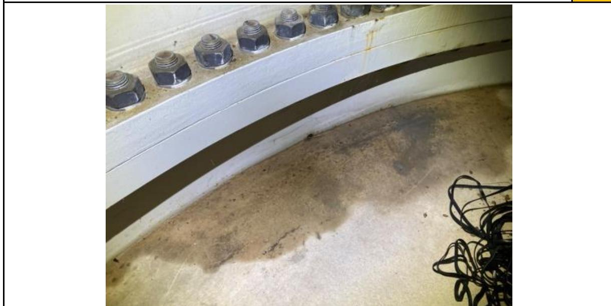
I0125136: Die Versiegelung des Fundaments ist stellenweise beschädigt. Die betroffenen Bereiche sollten instandgesetzt werden.
